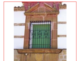
Casa de la Carrillera
