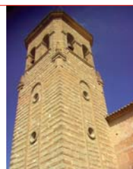
Torre de la Antigua Iglesia
